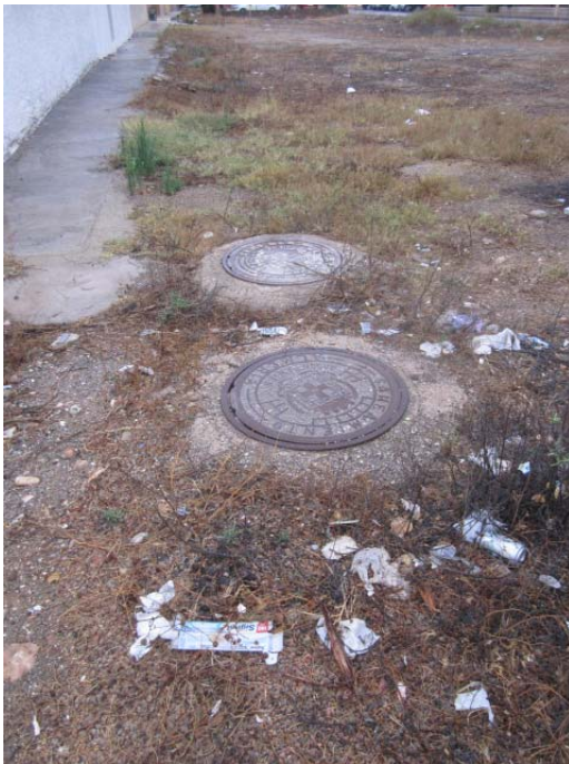
Red de Saneamiento. Arquetas de pozo de descarga y de paso.
