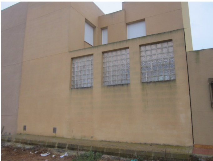
Servidumbre de ventilación. Acerado existente.
